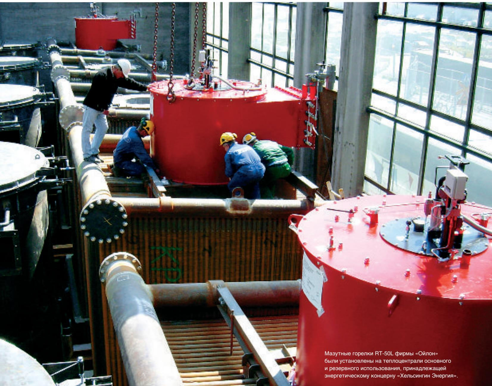
Мазутные горелки RT-50L фирмы «Ойлон» были установлены на теплоцентрали основного и резервного использования, принадлежащей энергетическому концерну «Хельсингин Энергия».
